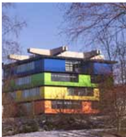
Fachada lateral del laboratorio XLab
