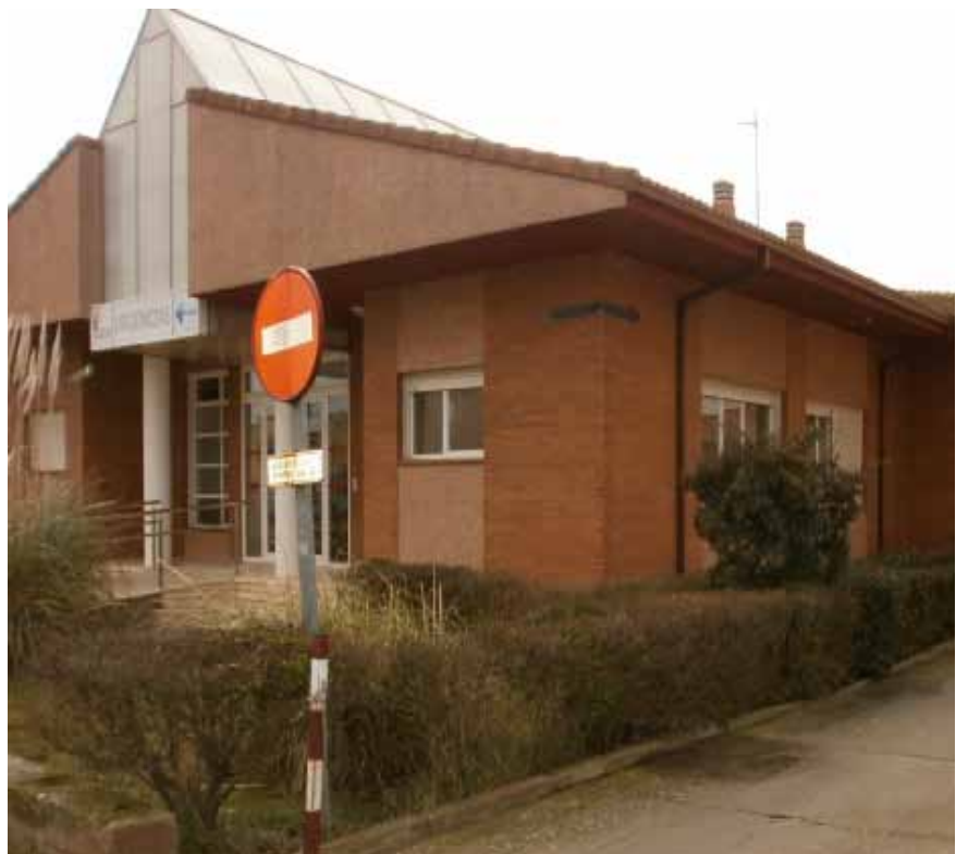
Entrada de Urgencias
